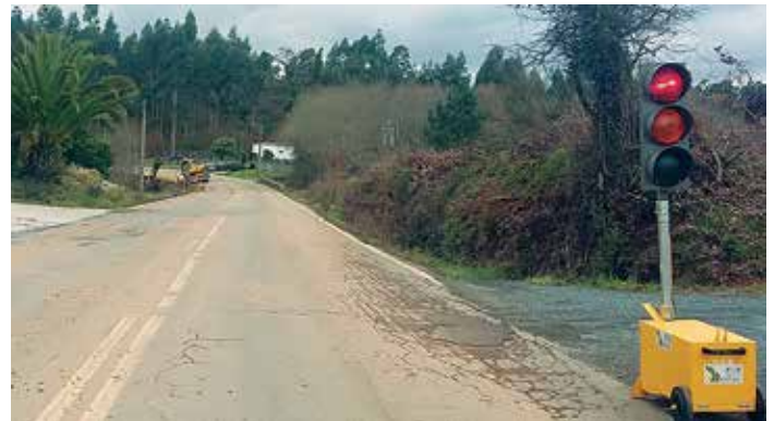
Os traballos requiren cortes puntuais dun dos carrís da estrada comarcal
