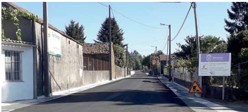
Lamas contará cunha nova senda peonil que se enlazará coa que actualmente se está a finalizar e que cruza este núcleo
